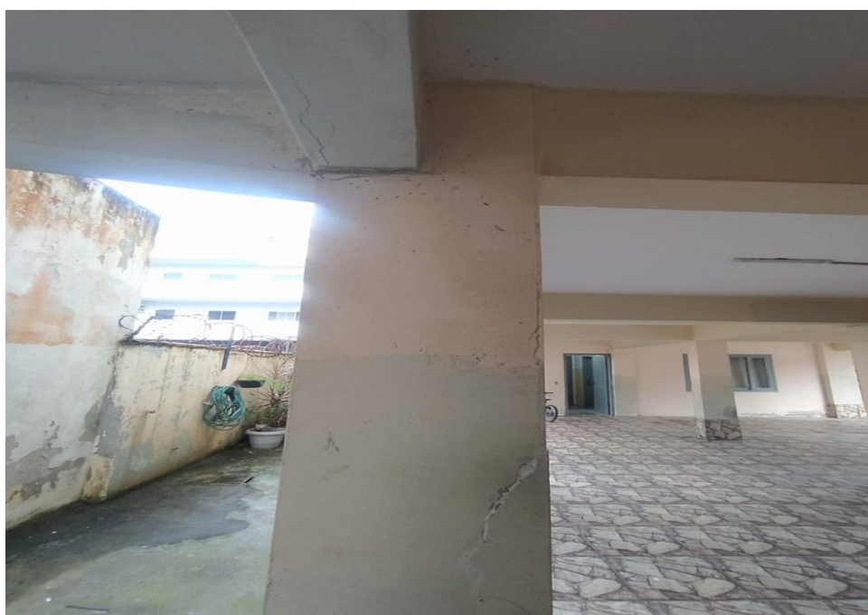
F10 – Coluna lateral com fissura vertical e presença de água. Intervenção: Grupo 3.
