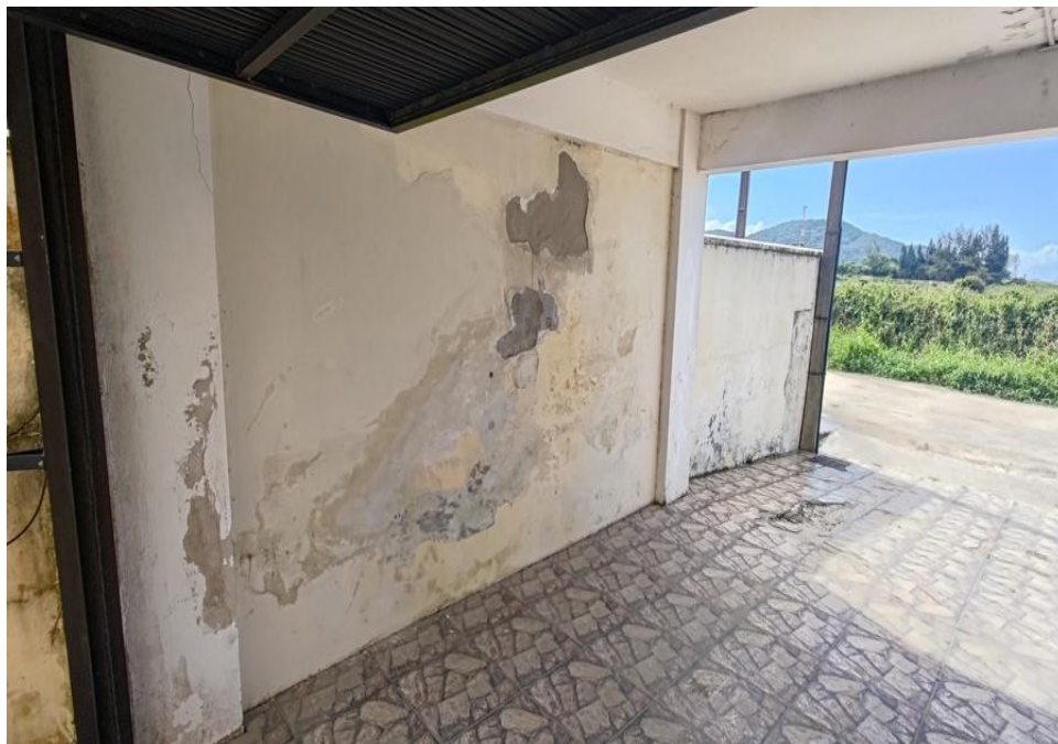
F01 – Vista interna da garagem – parede com reboco destacado e coluna com fissura. Indica a necessidade de remoção de reboco e recomposição (Grupo 2 e 7).
