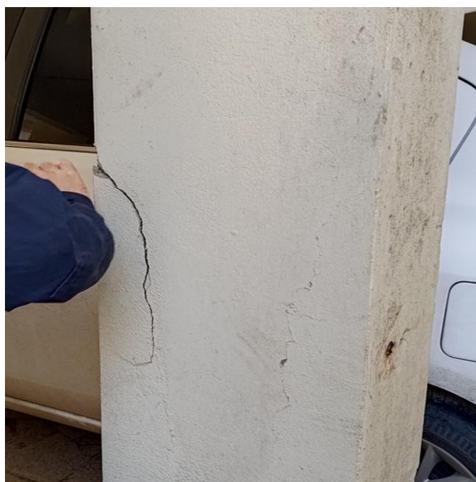
F06 – Coluna interna com fissura vertical de abertura significativa – trinca ativa. Intervenção: Grupo 3
