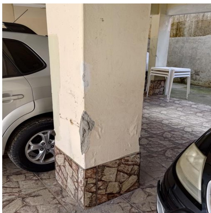
F04 – Coluna interna com base deteriorada e destacamento de concreto. Intervenção: Grupo 3.
