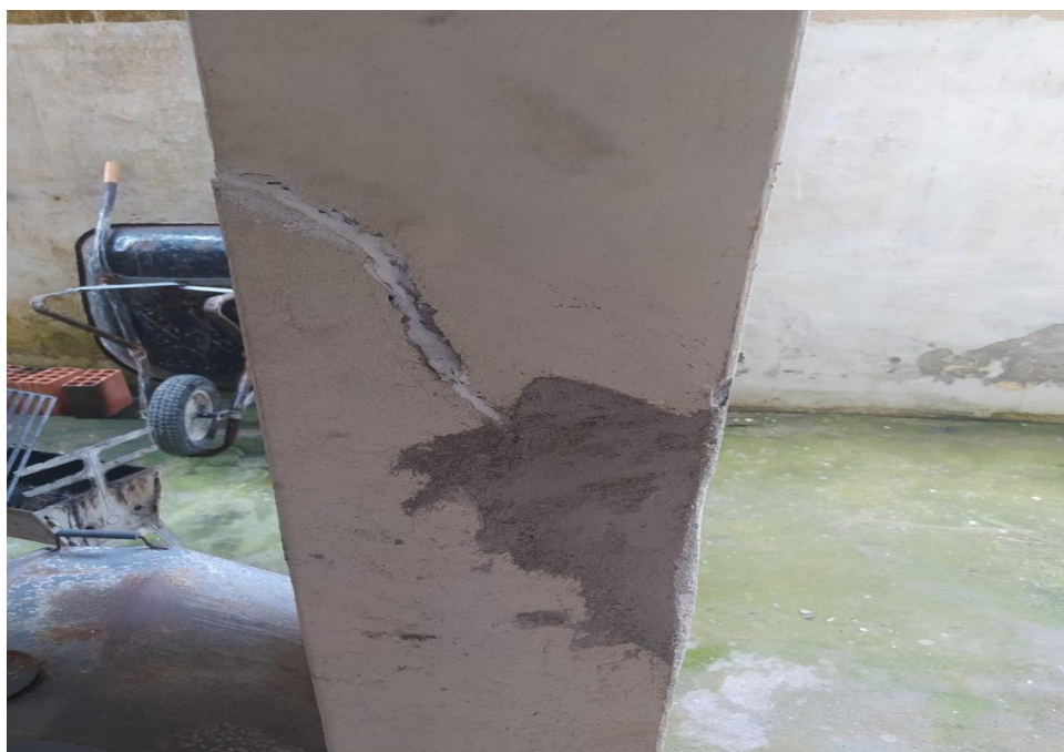
F08 – Coluna com fissura diagonal severa (já com início de selagem no campo). Intervenção: Grupo 3.
