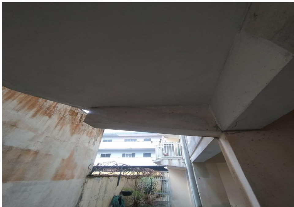
F11 – Viga lateral com fissura horizontal e manchas de umidade. Intervenção: Grupo 4.
