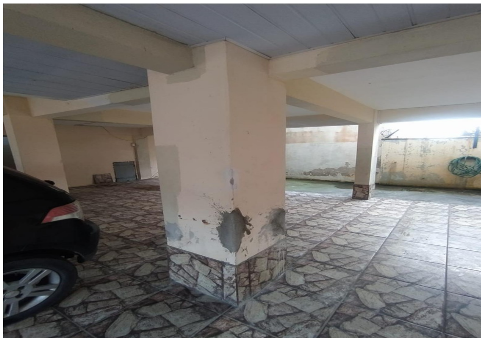
F09 – Vista geral da garagem com colunas com base danificada. Intervenção: Grupos 3 e 7.
