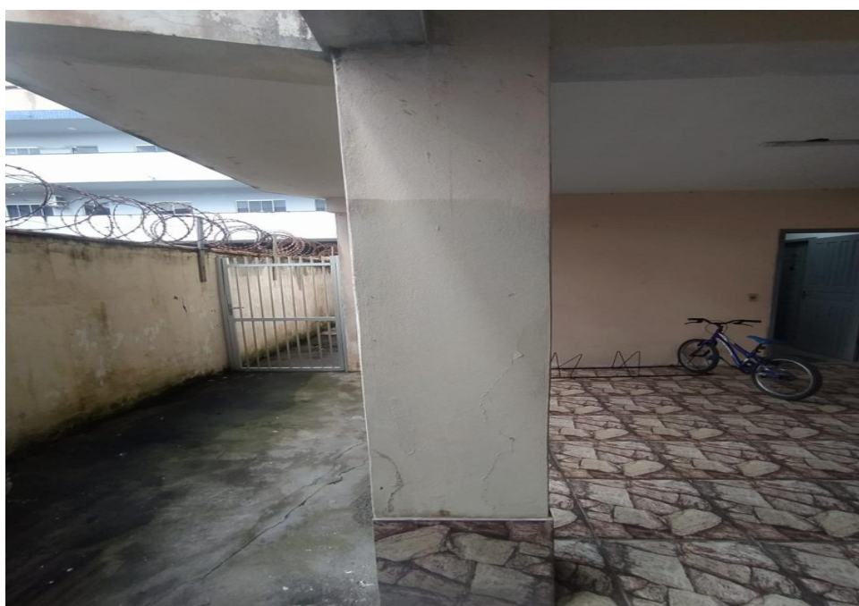
F16 - Pilastra com reboco deteriorado na base. Intervenção: Grupos 2 e 7.
