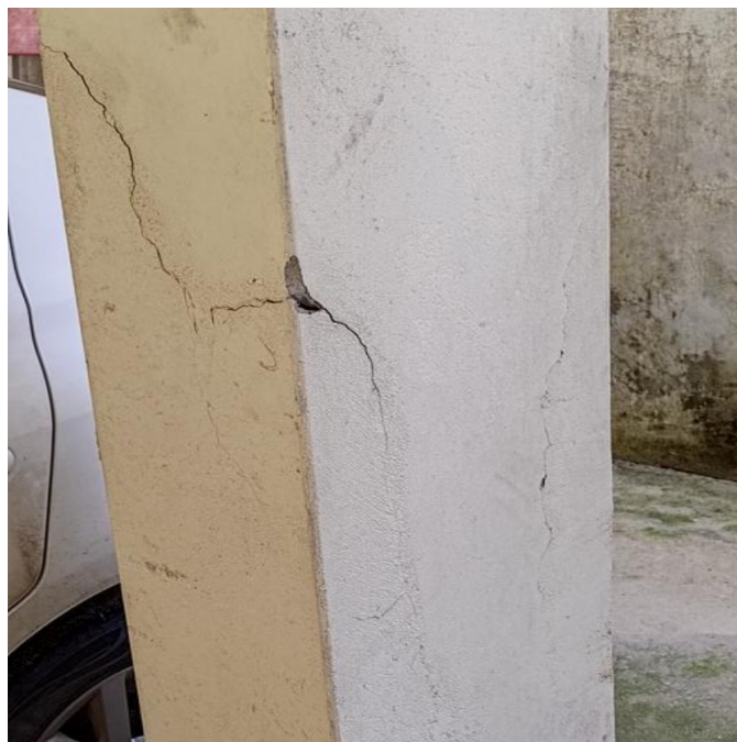
F05 – Coluna interna com fissuras verticais e pintura destacada. Intervenção: Grupos 3 e 7.
