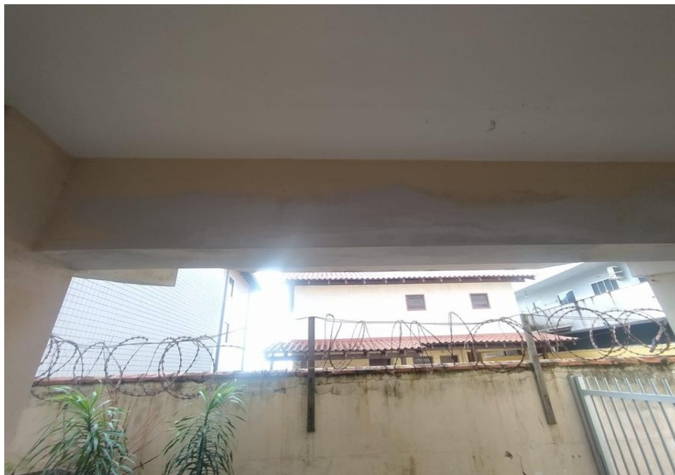
F15 - Viga lateral com fissura horizontal e mancha de umidade. Intervenção: Grupo 4 e 7.
