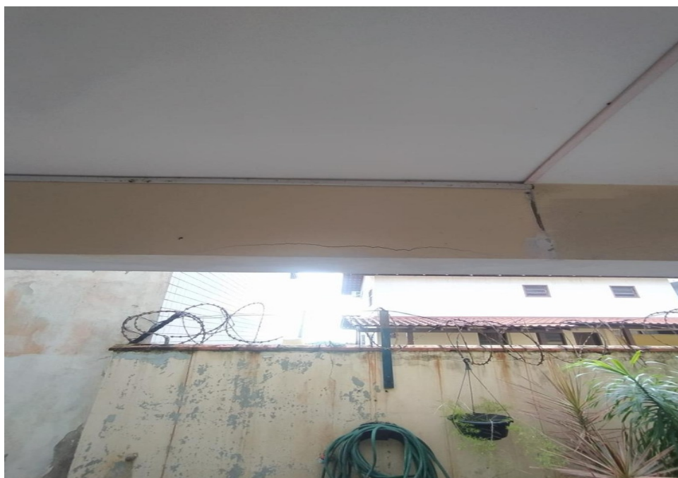
F14 - Viga lateral com fissura horizontal e mancha de umidade. Intervenção: Grupo 4.
