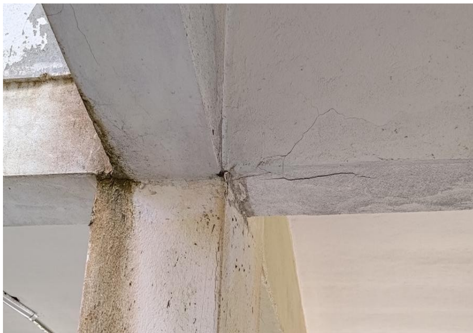
F07 – Nó viga-pilar com fissuras convergentes – situação crítica. Intervenção: Grupos 3 e 4.
